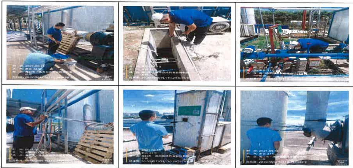
(二) 现场监测照片
