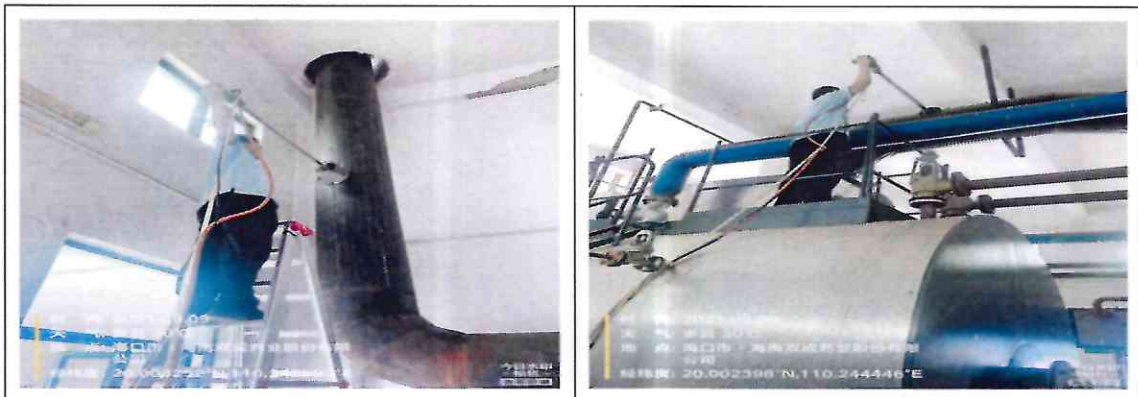
(二) 现场监测照片
