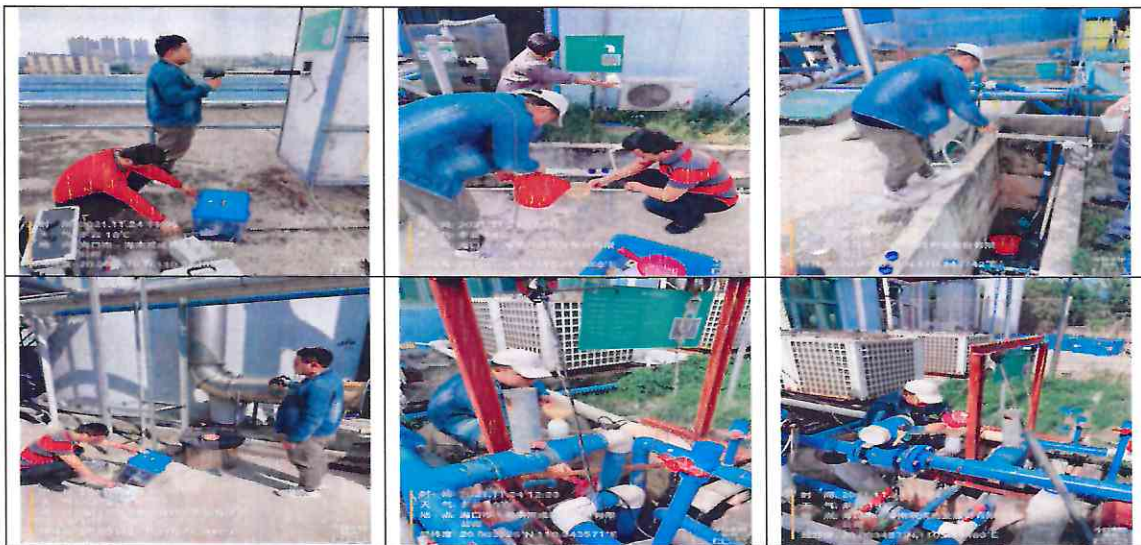
(二) 现场监测照片
